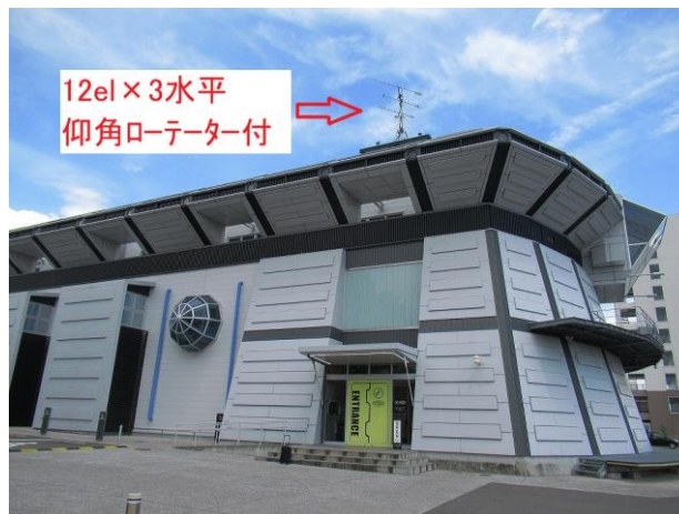
写真4 12el×3 水平八木 (仰角ローテーター付)
